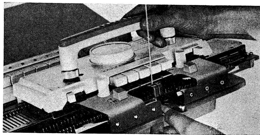
(12) Manténgase el cabo de la hebra y accíonese el carro enhebrado de derecha a izquierda.
